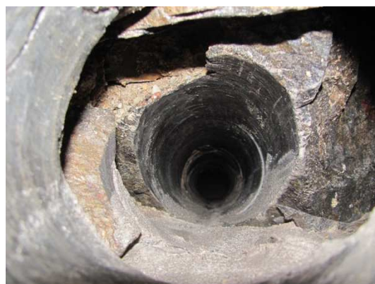
dutiny ve stěně vrtu, těsně za vzdušným lícem
