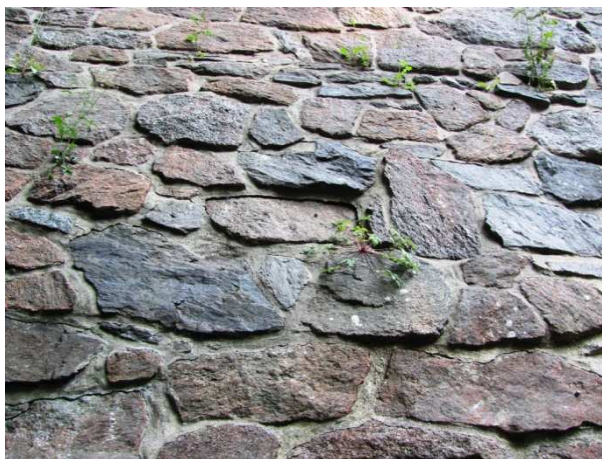
detail vzdušního líce, uvolněný blok
