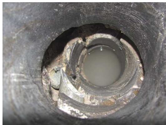
dutiny ve stěně vrtu, těsně za vzdušným lícem odvodňovací trubička
