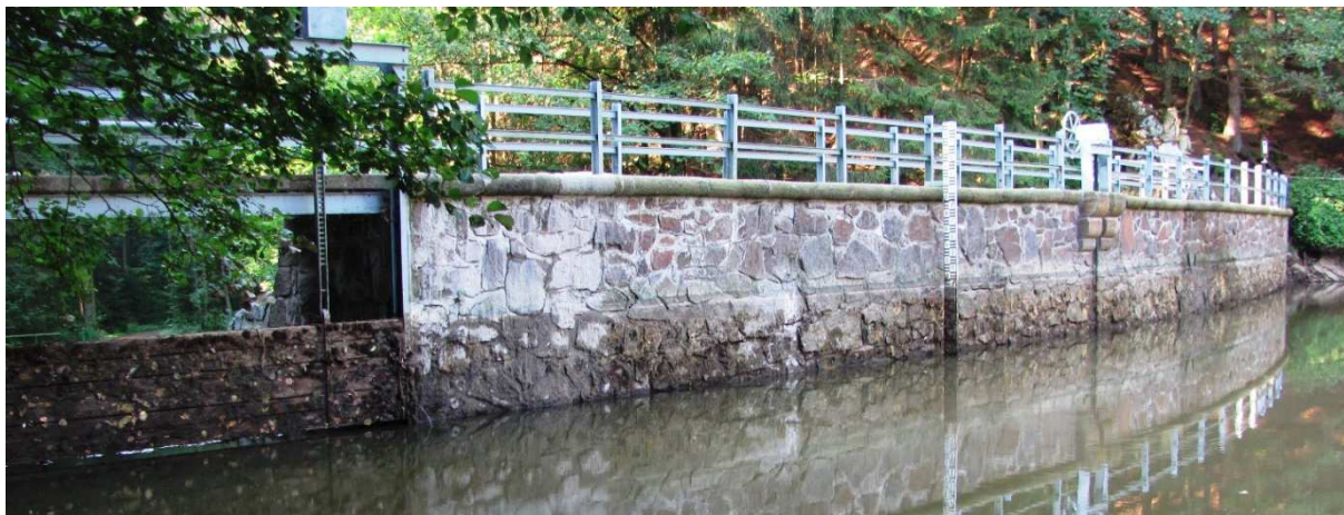
levá část návodního líce, hradící stavidlová konstrukce
