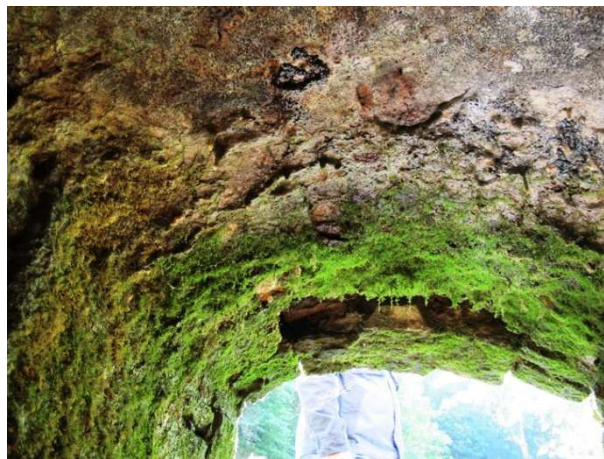
poškození ve stropě na konci štolý
