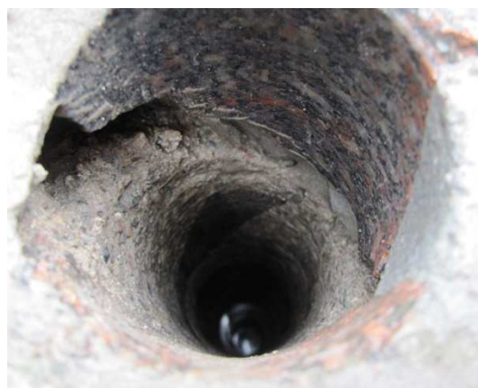
dutiny ve stěně vrtu pod korunou hráze
