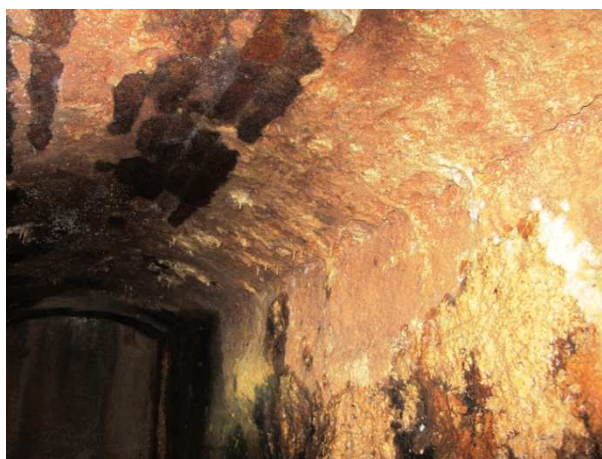
strop a levá stěna odpadní štoly s výluhy
