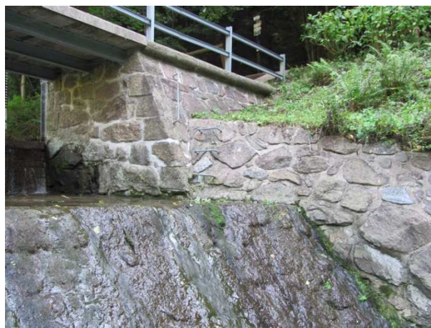
levá stěna bezpečnostního přelivu, skluz
